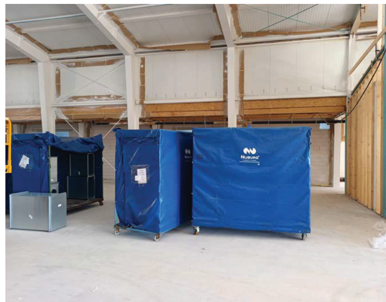
De prefabkarren zorgen ervoor dat alle materialen netjes en stofvrij op de bouw aankomen en direct verwerkt kunnen worden.
