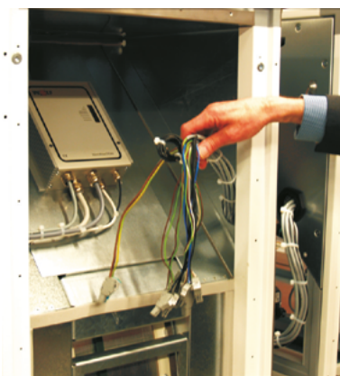
Afb. 5.5 Kabelstrengen in het afgeschuinde deel van het warmtewiel trekken.
