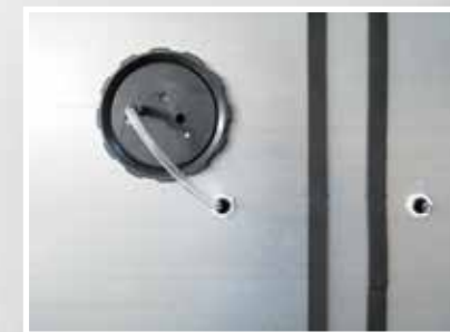
Manometerslang in de deur
